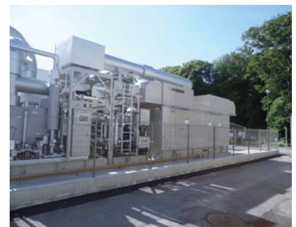
高崎工場に導入したコージェネレーションシステム
