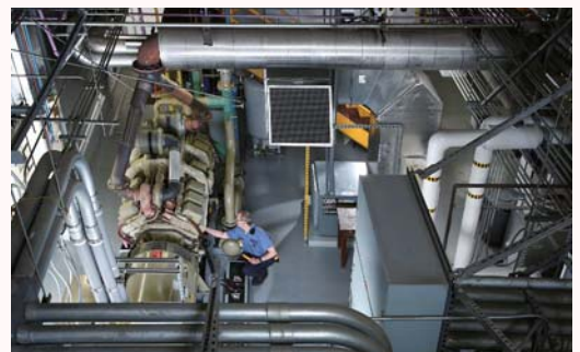
オフィスビルの地下に設置された発電設備のメンテナンス作業の様子
