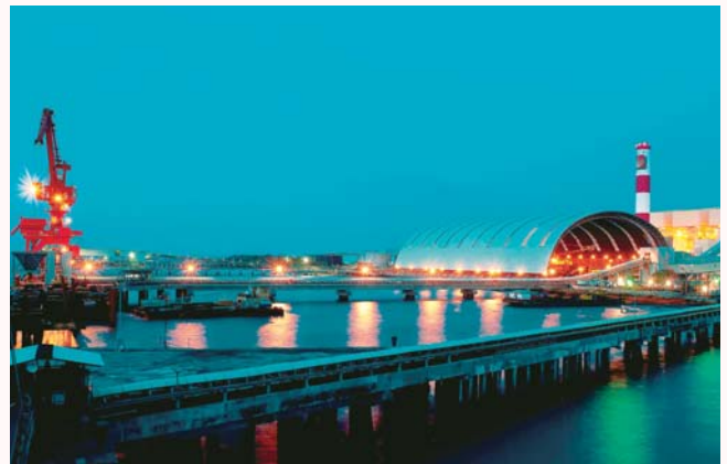
セブ島の発電所
