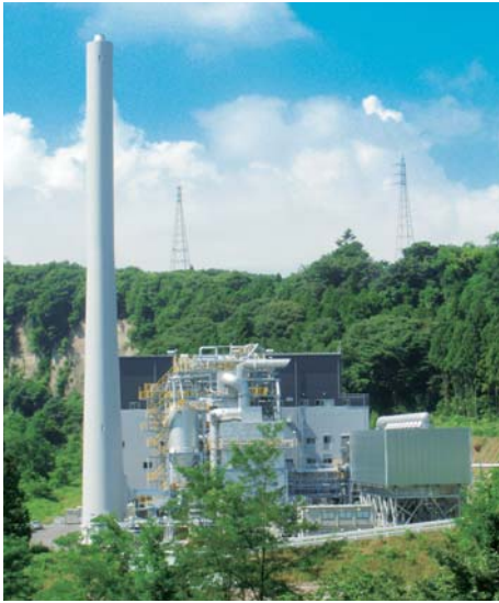
吾妻木質バイオマス発電所
