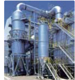
処理施設の一部
