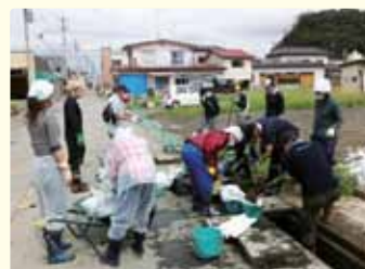
側溝の泥出し作業を行うボランティア団
