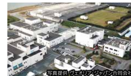
浜松市公共下水道終末処理場(西遠処理区)
