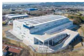
鶴ヶ島IIロジスティクスセンター
