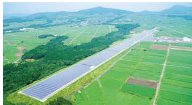
鹿児島県枕崎市枕崎空港第一発電所、第二発電所
