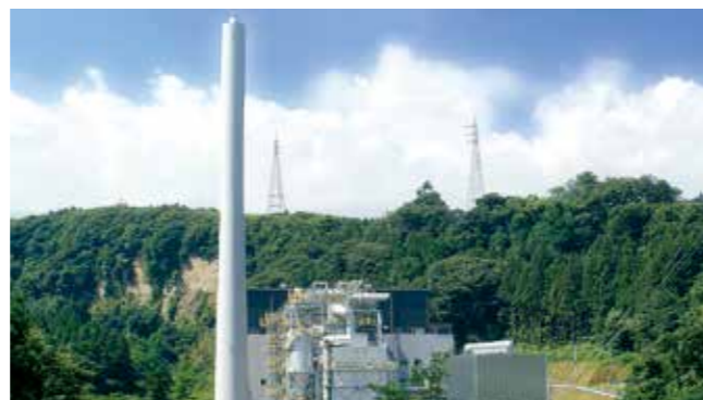
吾妻木質バイオマス発電所
