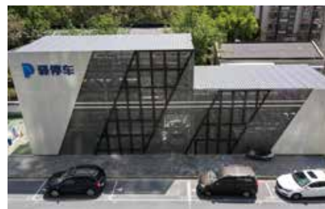
中華圏で駐車場運営管理事業を手掛ける出資先「首程控股有限公司」の立体駐車場
