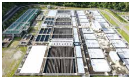
南部山浄水場（宮城県白石市）
