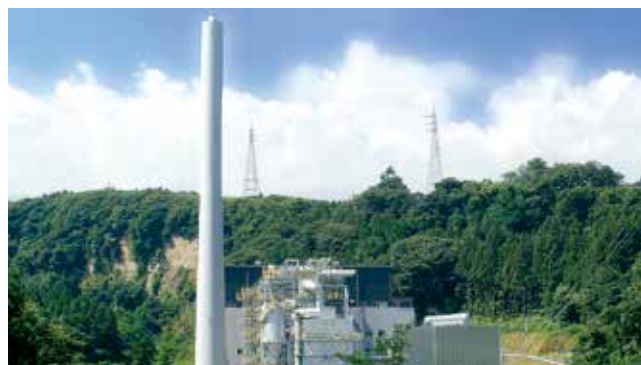
吾妻木質バイオマス発電所
