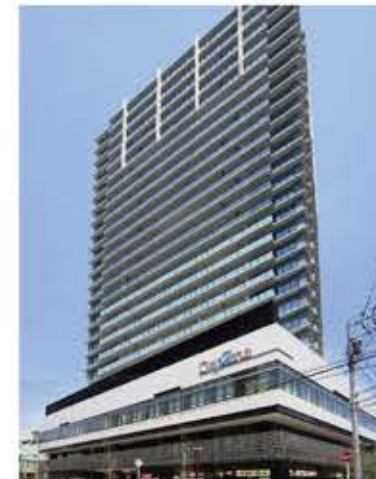
ライオンズタワー柏【柏駅東口街区地区】
