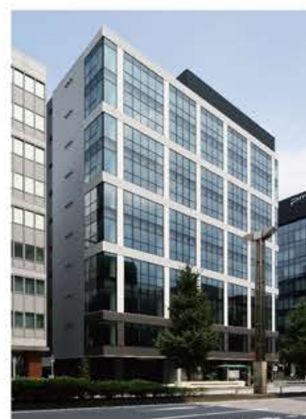
オリックス八重洲通ビル
