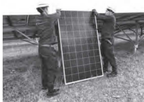
太陽光パネルを交換する様子
