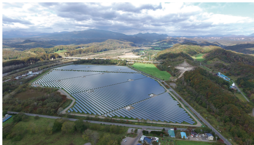
オリックスグループが所有する白老発電所
