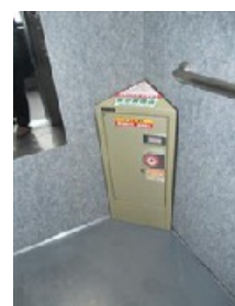
エレベーターに 緊急装備品を設置
