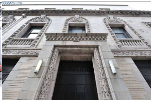
増築改修後のビル外観
