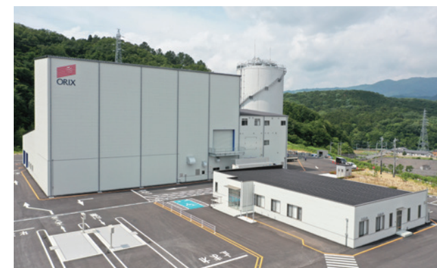
バイオガス発電施設(オリックス資源循環 寄居バイオガスプラント)
