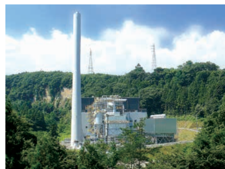
吾妻木質バイオマス発電所
