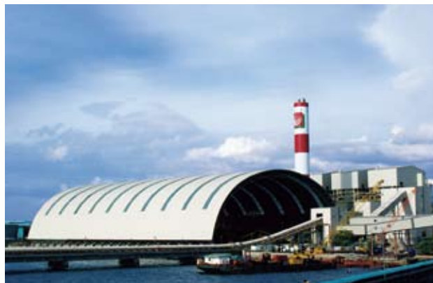
セブ島の発電所
