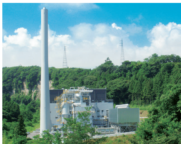
吾妻木質バイオマス発電所
