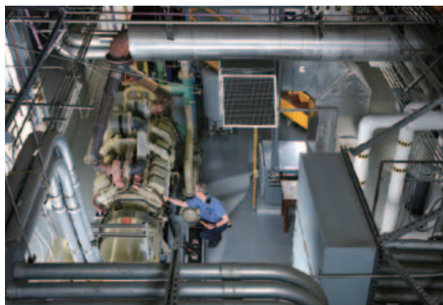
オフィスビルの地下に設置された発電設備のメンテナンス作業の様子
