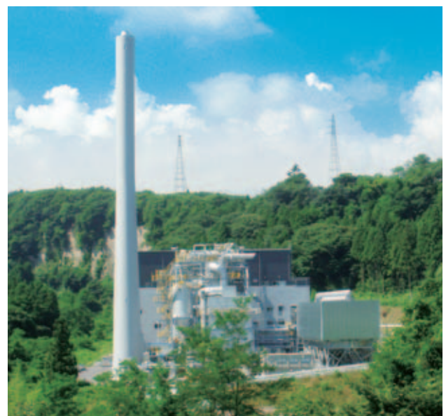
吾妻木質バイオマス発電所
