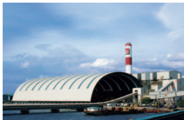
セブ島の発電所
