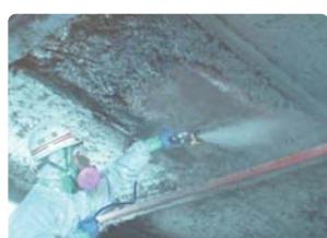
ケレンなどによる手作業での除去前に、アスベストの飛散を防ぐための湿潤剤としてゲル化溶液(エコモイスター)を散布します。エコモイスターは食品添加物のため、人体には無害。また浸透性が高いので、アスベストの飛散はほとんどありません。
