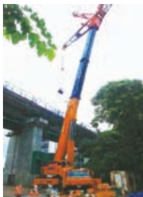
東日本大震災による補修工事で稼働する大型クレーン車
