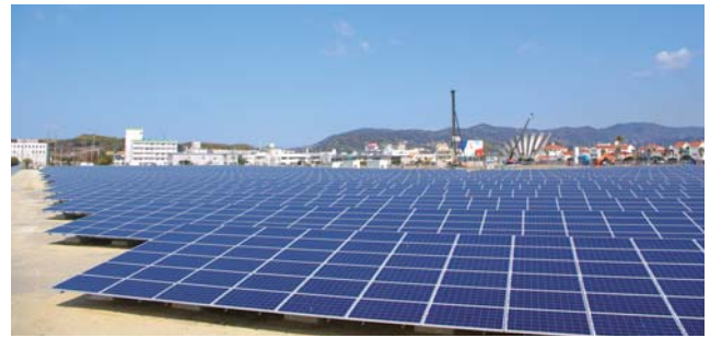
オリックス淡路メガソーラー発電所（兵庫県淡路市）
