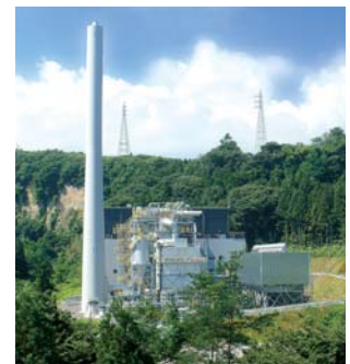
吾妻木質バイオマス発電所
