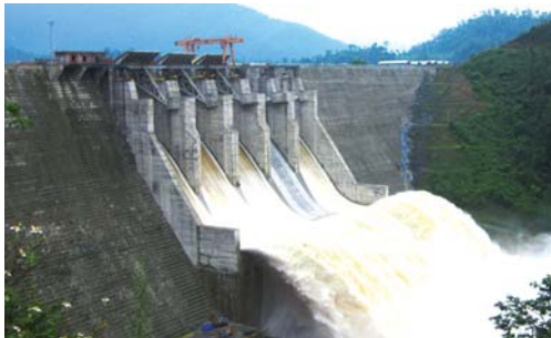
BPCが保有・運営するDakMi 4発電所
