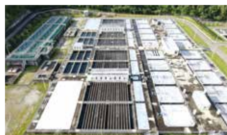
南部山浄水場（宮城県白石市）
