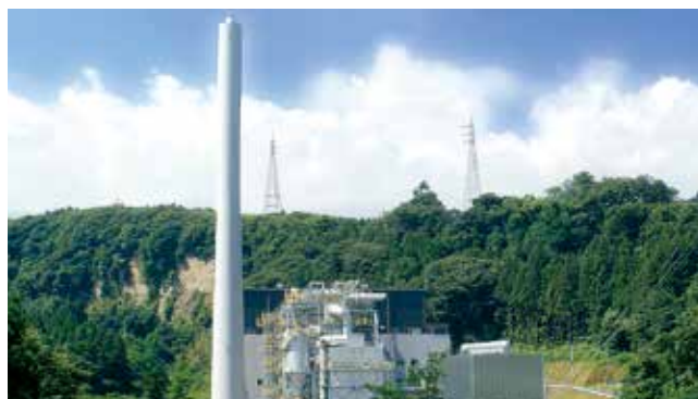
吾妻木質バイオマス発電所
