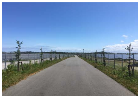
周辺道路の整備
