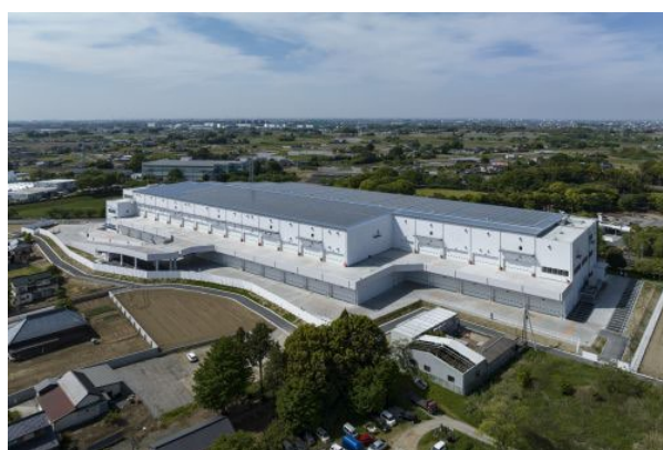
「加須ロジスティクスセンター」外観
