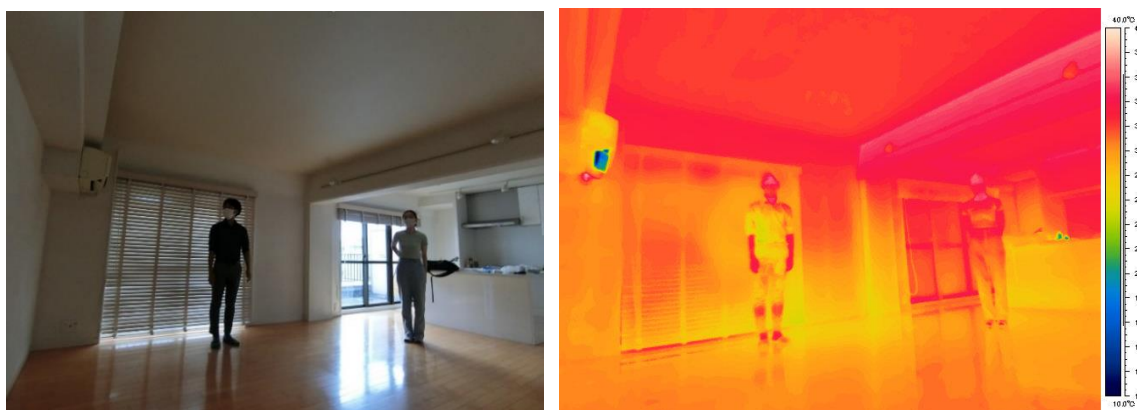
断熱性能・日射遮蔽性能の不足により、住戸内の温度環境が均一でない様子
