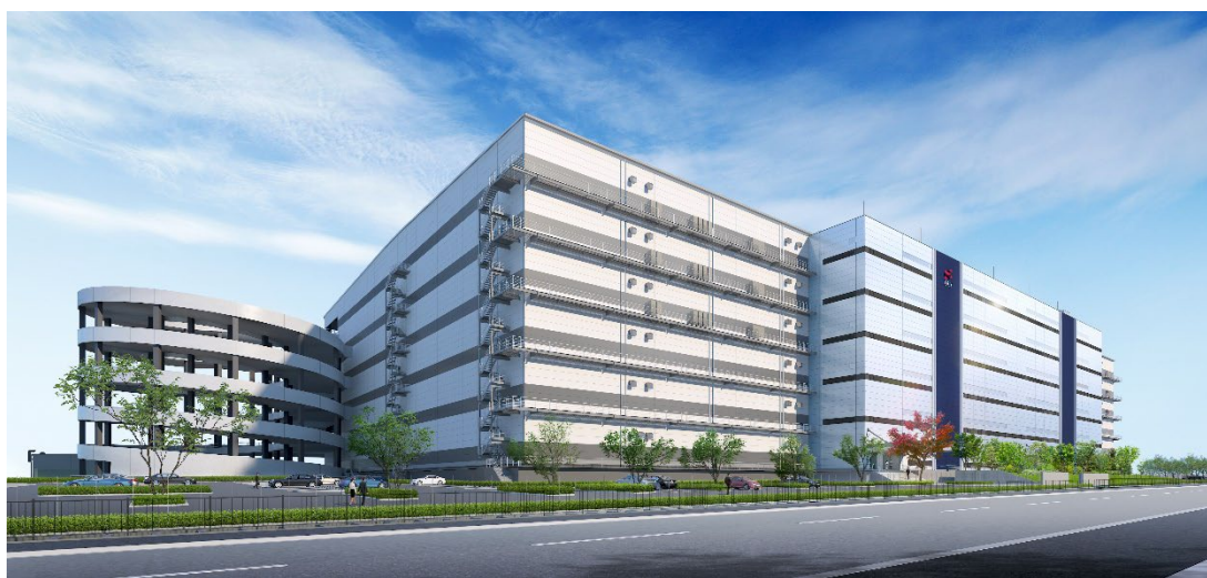
「厚木Ⅲロジスティクスセンター」外観イメージ
