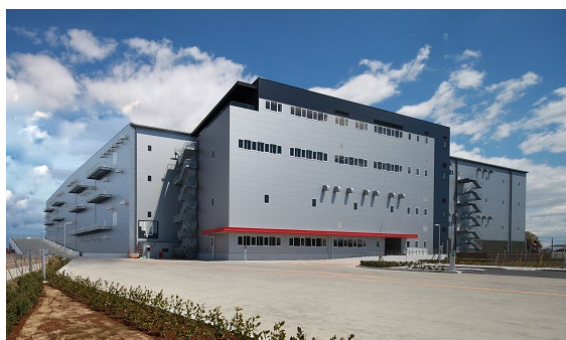
「松伏ロジスティクスセンター」外観
