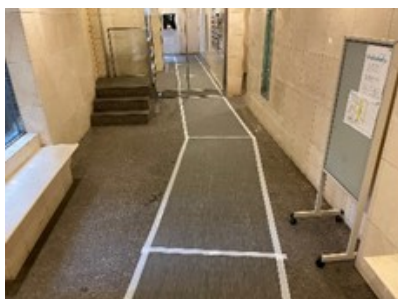
リサイクル養生シート使用例
