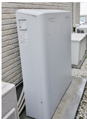
設置された蓄電池
