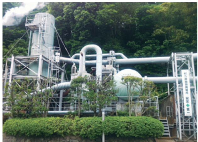
杉乃井地熱発電所
