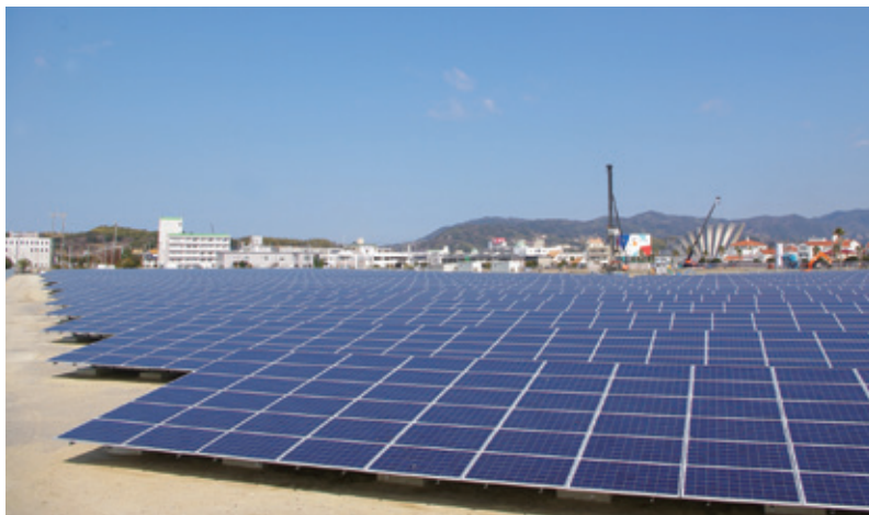
オリックス淡路メガソーラー発電所(兵庫県淡路市)
