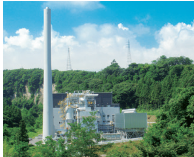
吾妻木質バイオマス発電所
