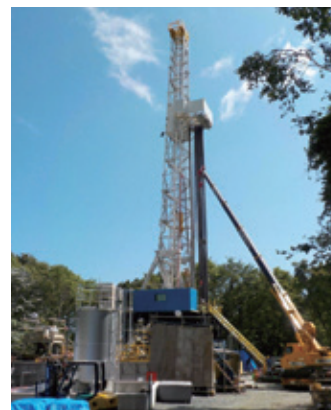
函館市南茅部における掘削現場
