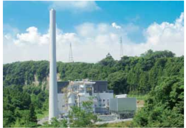
吾妻木質バイオマス発電所
