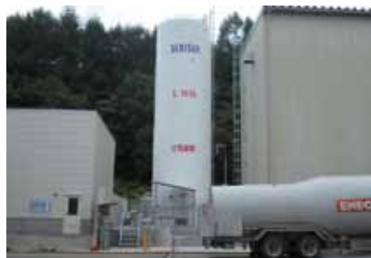
岩手工場に導入したLNGサテライトタンク
