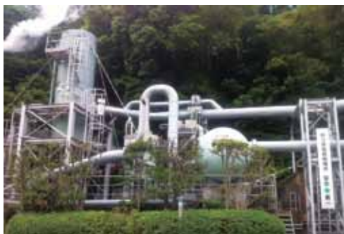
自家用では国内最大級となる杉乃井ホテルの地熱発電所
