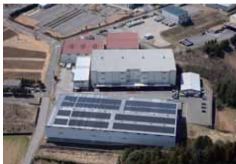
パネル2,300枚を設置した倉庫の屋根(最大出力345.8kW)
