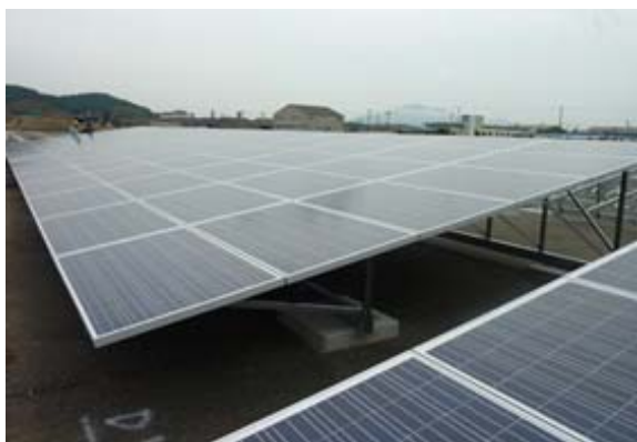
(太陽光パネル設置工事の様子：福島県)
