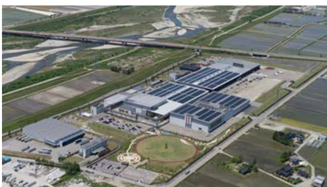
(飲料メーカーの工場屋根に設置した太陽光発電システム)
