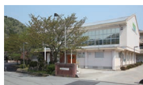
小学校の体育館を利用した植物工場
