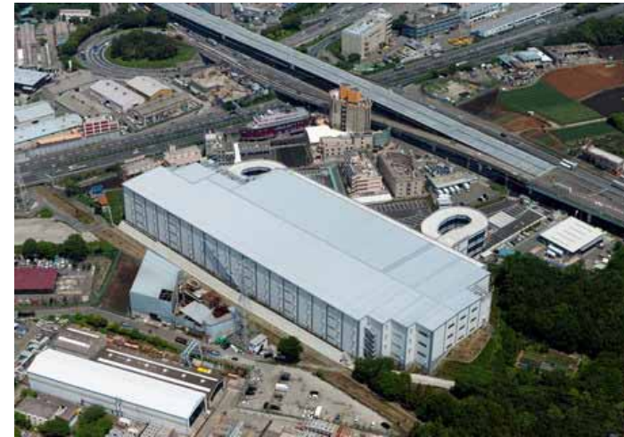
横浜町田ICロジスティクスセンター
